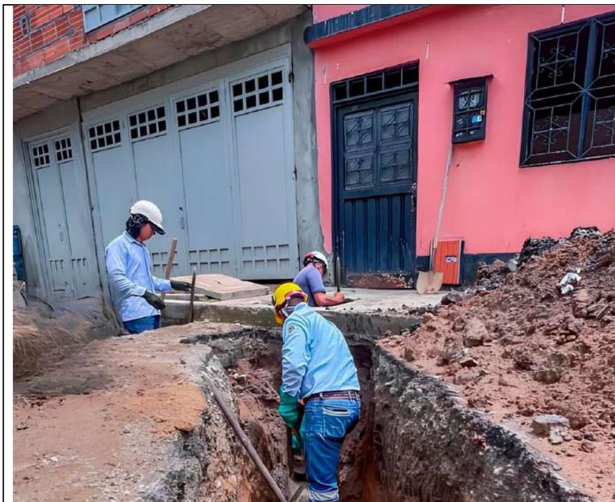
Foto 3. Instalación Tubería
